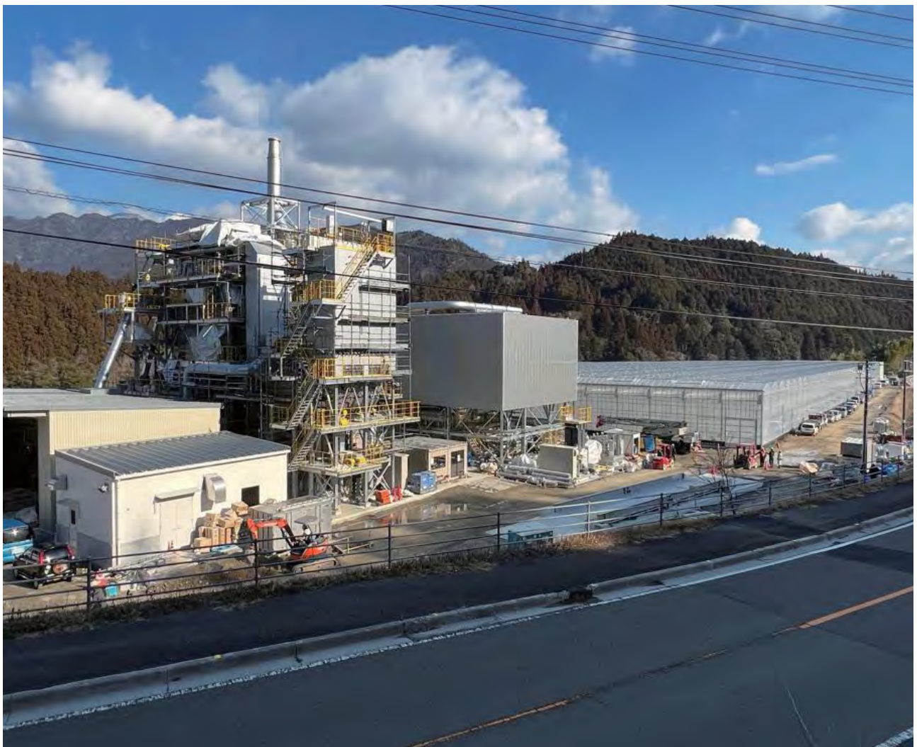
建設中の木質バイオマス発電所（2022年2月現在）
