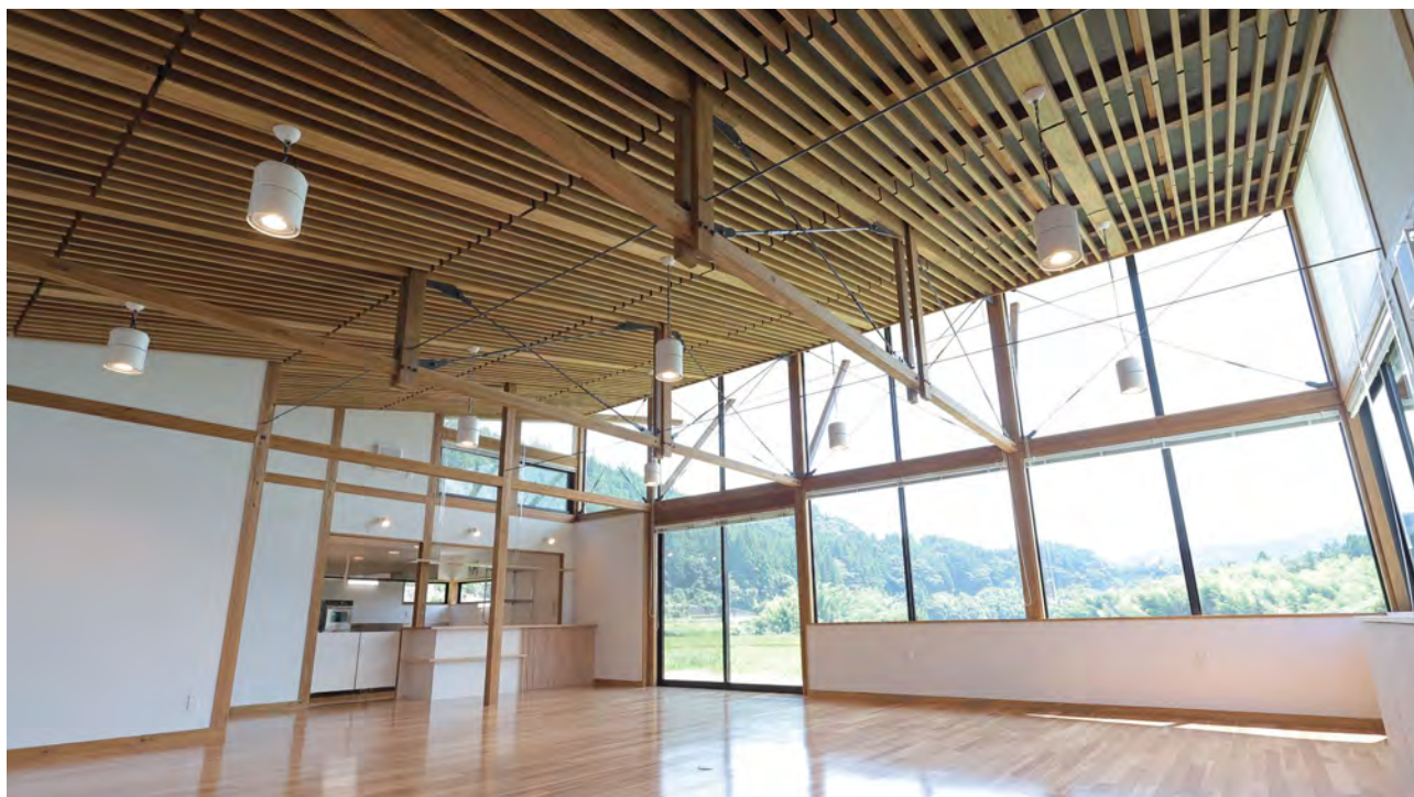
地域材を活用した建築事例（集落活動センターなめかわ）
